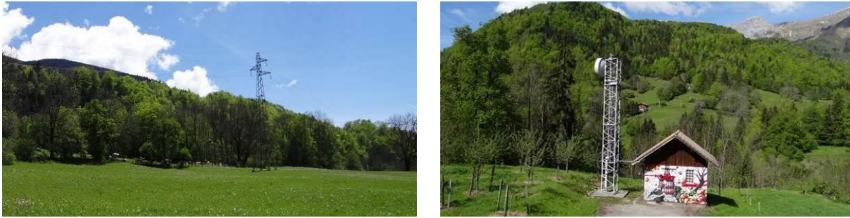
Photo 11 : Ligne à haute tension et antenne de transmission radioélectrique
