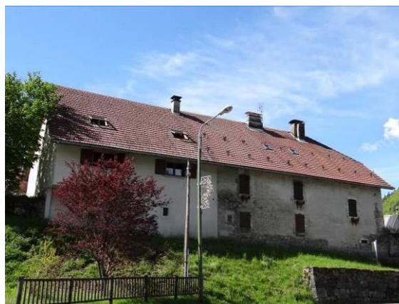
Photo 2 : Ancienne maison forte divisée en logements (R+1+combles aménagés)
