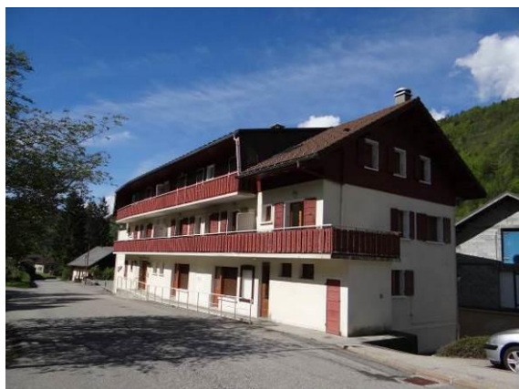
Photo 1 : Ancien hôtel réhabilité en logements (R+1+combles aménagés côté rue)
